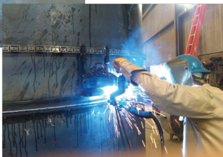
Li'l Runner con el riel flexible para la fabricación del tanques
